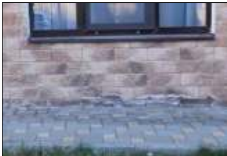
Фото 59, Фото 60 – Следы намокания фасада корпуса №1.
