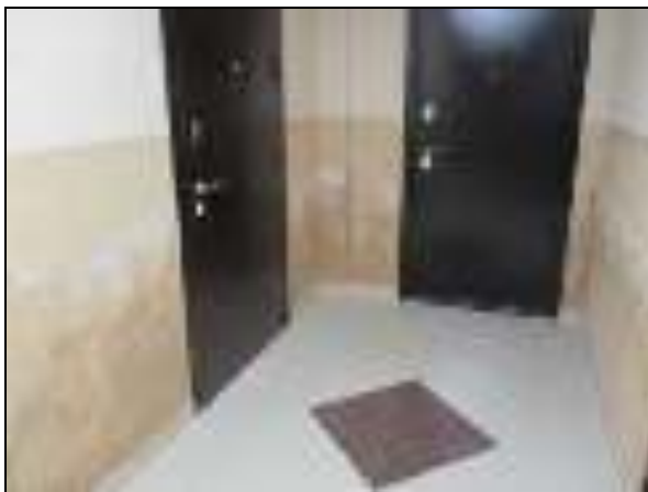
Фото 6, Фото 7- – Следы увлажнения стен, высолы в коридоре цоколя копуса №5.
