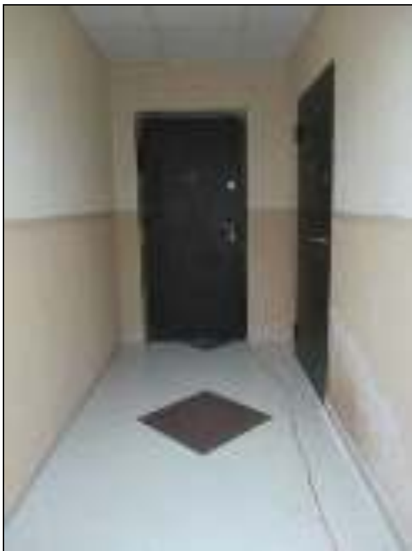
Фото 12, Фото 13 - Следы увлажнения стен, высолы в коридоре цоколя копуса №5.
