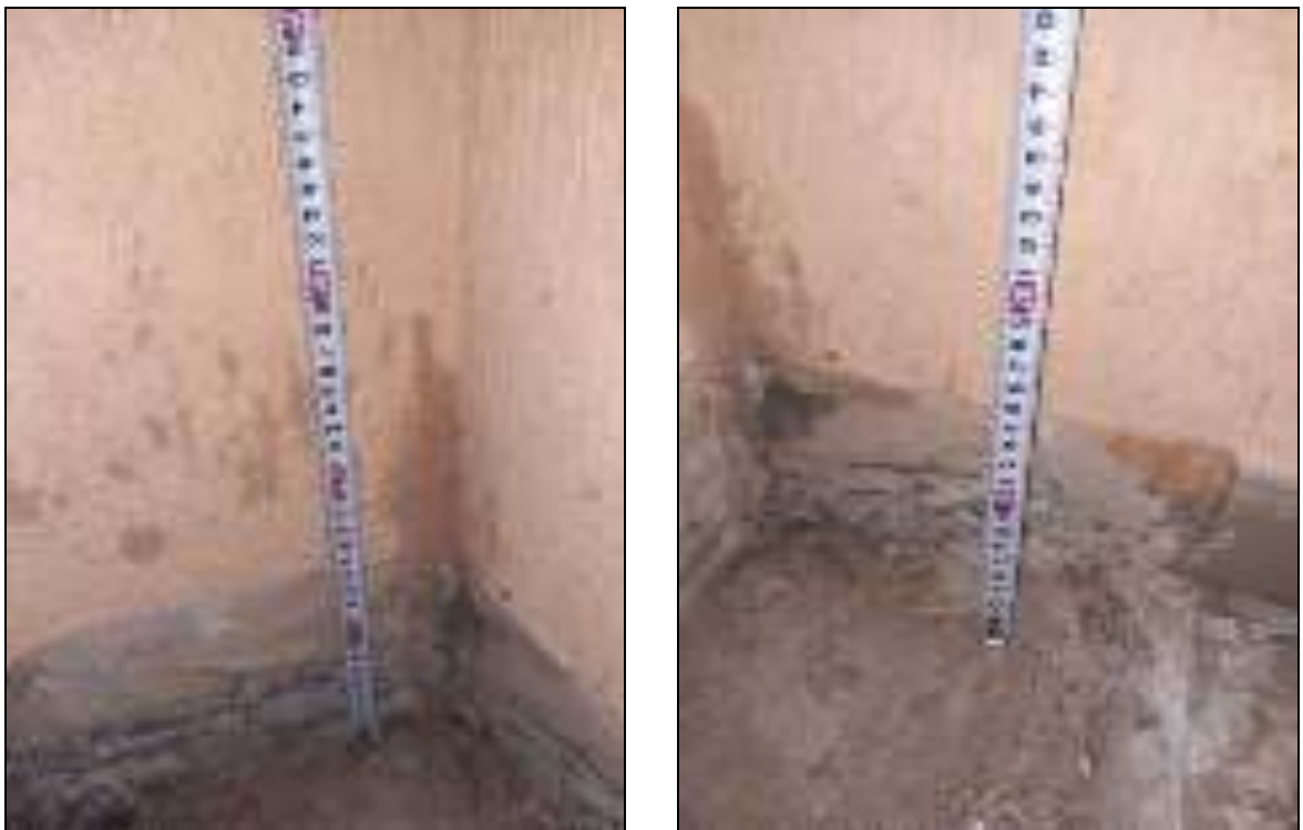
Фото 24, Фото 25 - Вскрытие напольного покрытия и штукатурки стен
