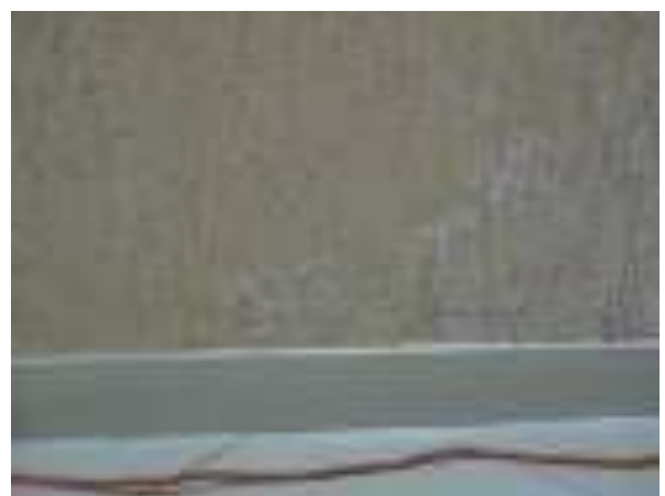
Фото 8, Фото 9 - – Следы увлажнения стен, высолы в коридоре цоколя копуса №5.
