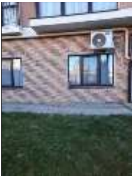
Фото 59, Фото 60 – Следы намокания фасада корпуса №1.
