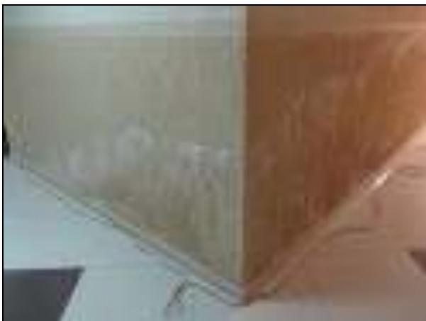
Фото 8, Фото 9 - – Следы увлажнения стен, высолы в коридоре цоколя копуса №5.
