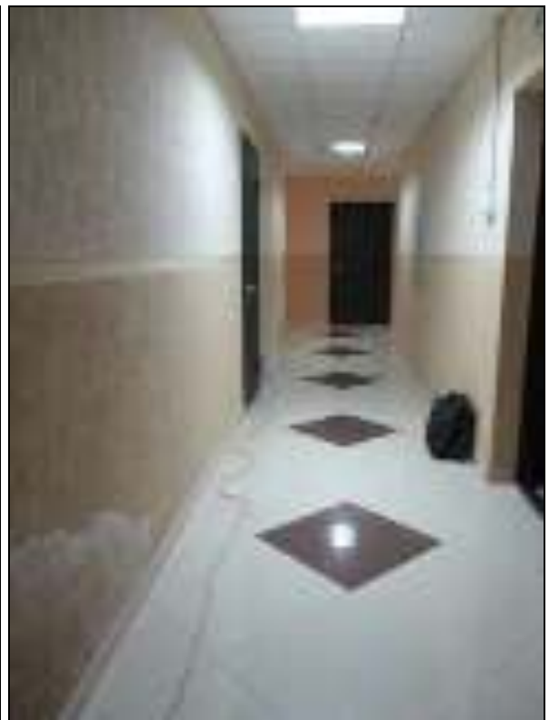
Фото 12, Фото 13 - Следы увлажнения стен, высолы в коридоре цоколя копуса №5.
