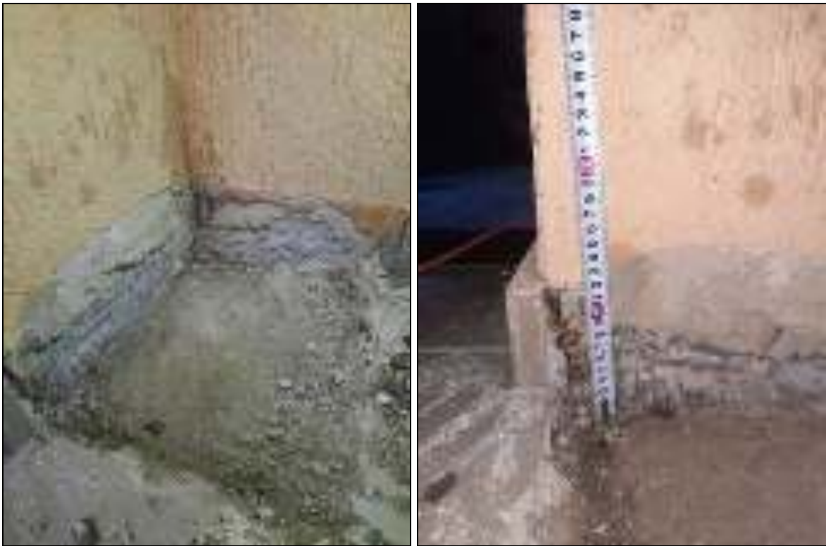
Фото 22, Фото 23 – Вскрытие напольного покрытия и штукатурки стен.
