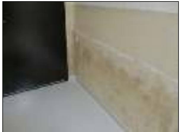
Фото 6, Фото 7- – Следы увлажнения стен, высолы в коридоре цоколя копуса №5.
