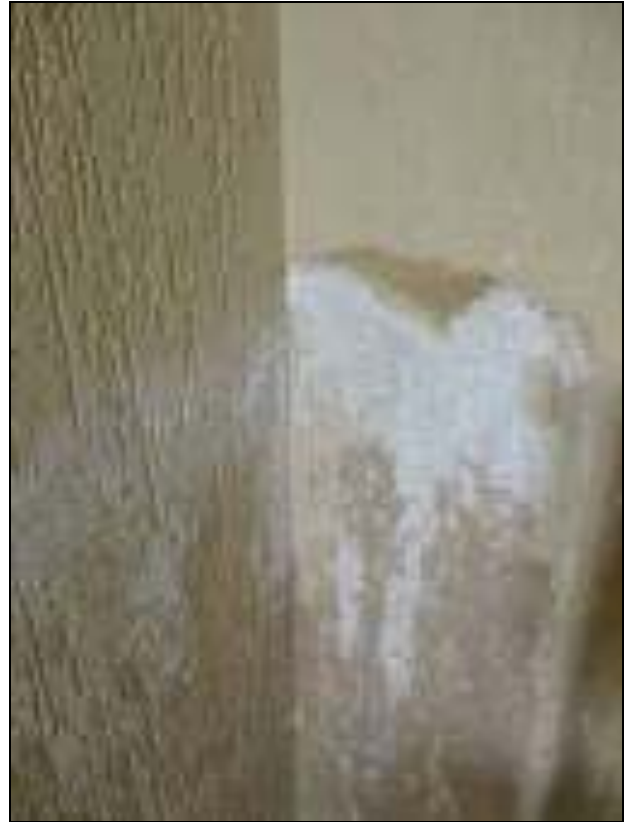
Фото 10, Фото 11 - Следы увлажнения стен, высолы в коридоре цоколя копуса №5.
