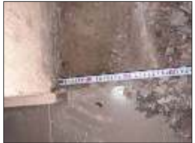
Фото 26, Фото 27 - Вскрытие напольного покрытия и штукатурки стен.
