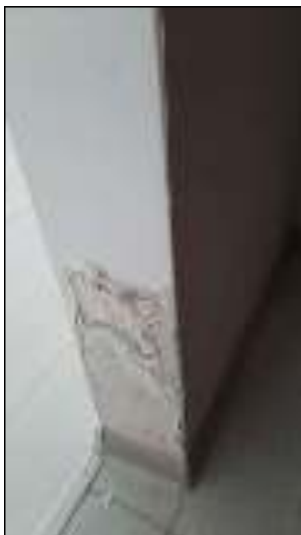
Фото 16, Фото 17 - Следы увлажнения стен в квартире №5ж. Отслоение обоев и шпатлевочного слоя (фото предоставленные собственником квартиры).
