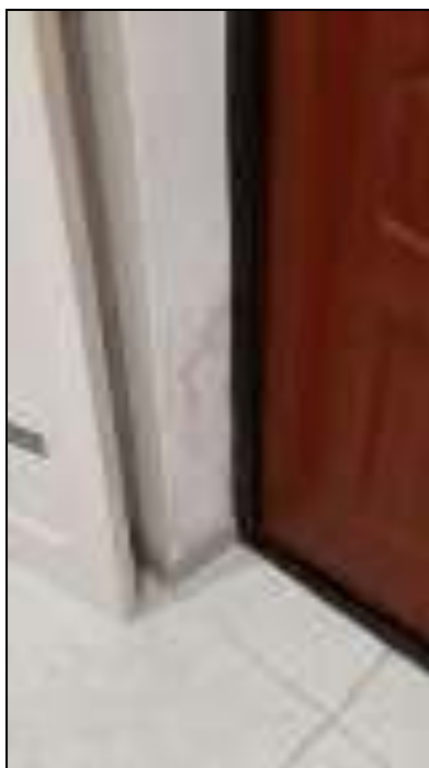
Фото 14, Фото 15 – Следы увлажнения стен в квартире №5ж. Отслоение шпатлевочного слоя.
