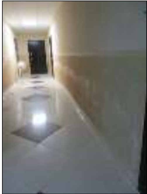
Фото 4, Фото 5 - – Следы увлажнения стен, высолы в коридоре цоколя копуса №5.
