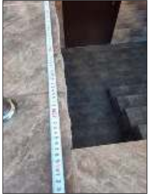
Фото 30, Фото 31 – Отступ стен входной группы цоколя (прямка) от наружных стен здания.
