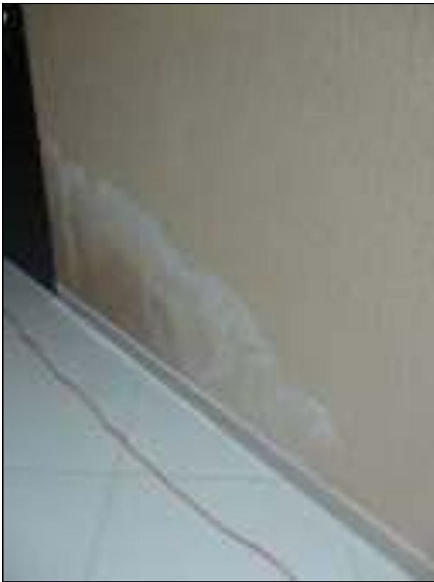
Фото 10, Фото 11 - Следы увлажнения стен, высолы в коридоре цоколя копуса №5.
