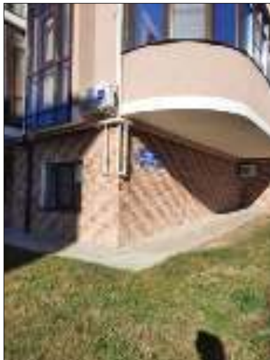
Фото 62, Фото 63 - Выступ балкона (корпус №1) относительно отмостки.
